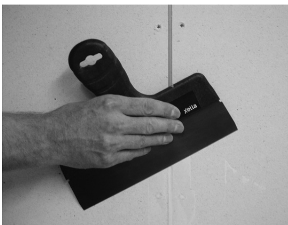
3. Fyll fugen helt med Fermacell Skjøtesparkel.
